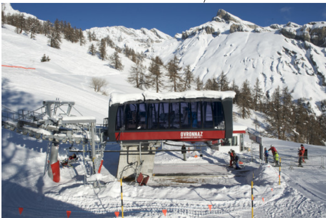
Foto: Sesselbahn in Ovronnaz
